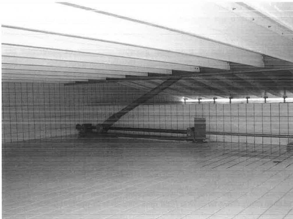
Le plancher vu de dessous.
